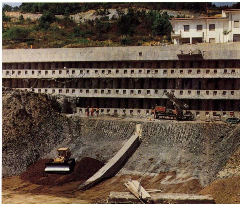
Figura 1.6. Fase costruttiva della paratia (P1).
