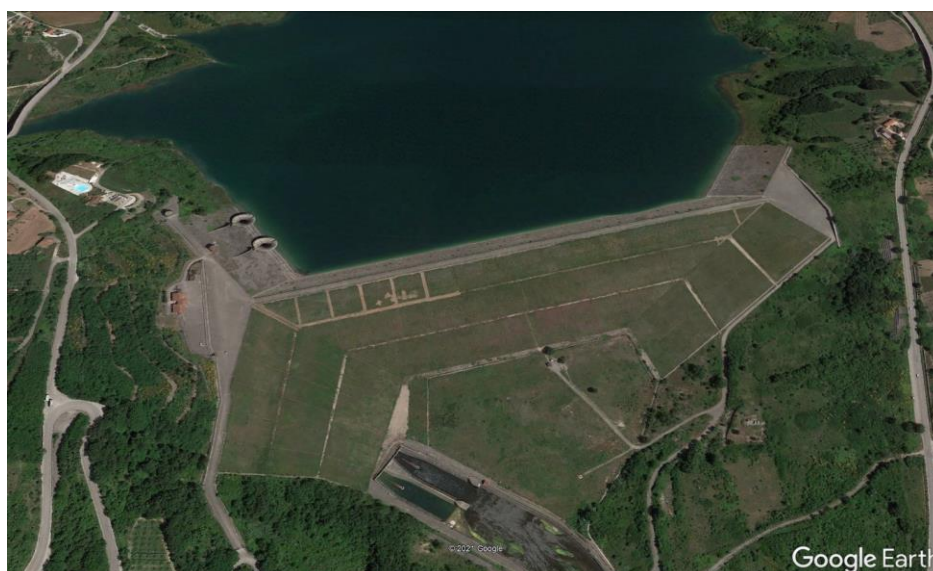
Figura 1.1. Vista aerea dello sbarramento.
