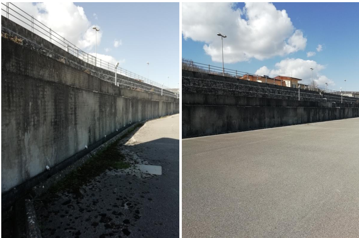
Figura 4.1. Viste laterali della paratia in sponda destra (sopralluogo del 25/02/2022).
