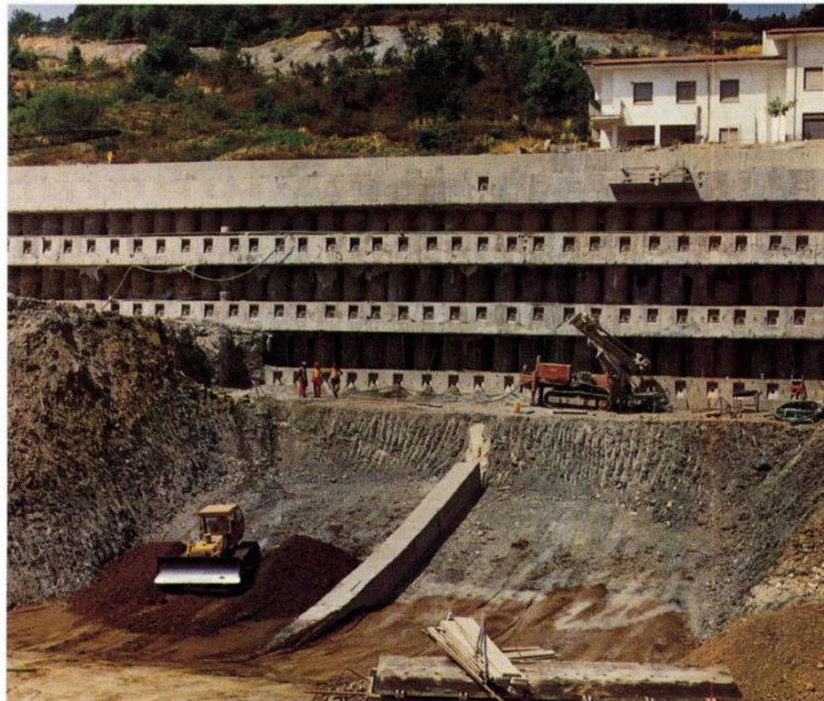
Figura 4.2 Costruzione della nuova paratia a protezione del piazzale della casa di guardia (1991)
