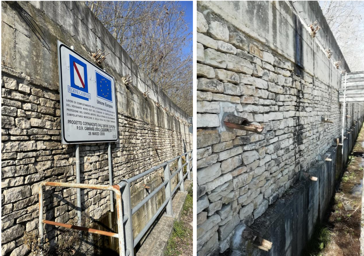
Figura 4.4 Paratia tirantata a protezione dello svicolo tra la SS 625 e la strada circumlacuale (2001)
