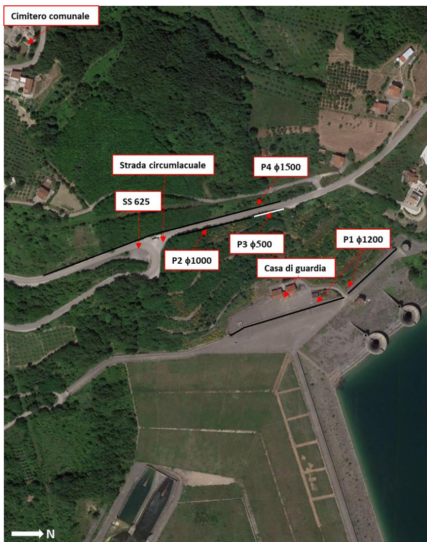
Figura 1.2 Vista aerea della sponda destra
