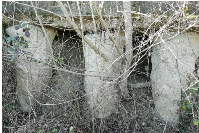
Figura 1.4 Paratia P2 (a valle della strada circumlacuale)
