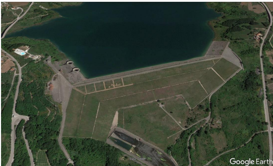
Figura 1.1 Vista aerea dello sbarramento
