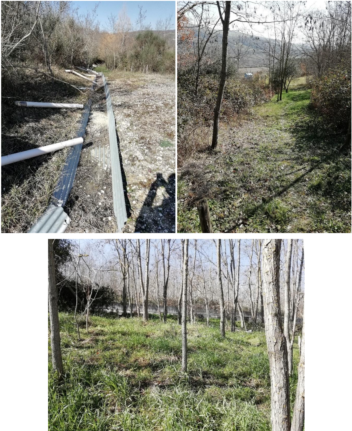
Figura 1.6 Evidenze intervento di stabilizzazione del 2001 (dreni sub-orizzontali, riprofilatura e riforestazione)
