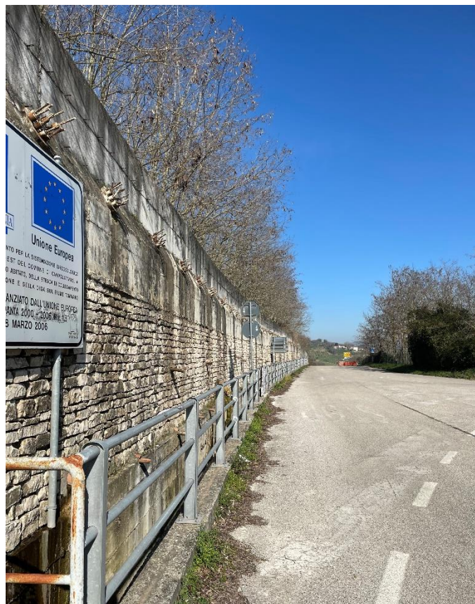
Figura 1.5 Paratia P4 (a monte della strada circumlacuale)
