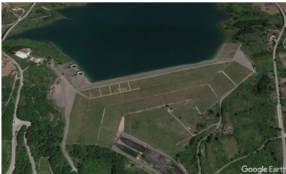
Figura 3.1 Vista aerea dello sbarramento
