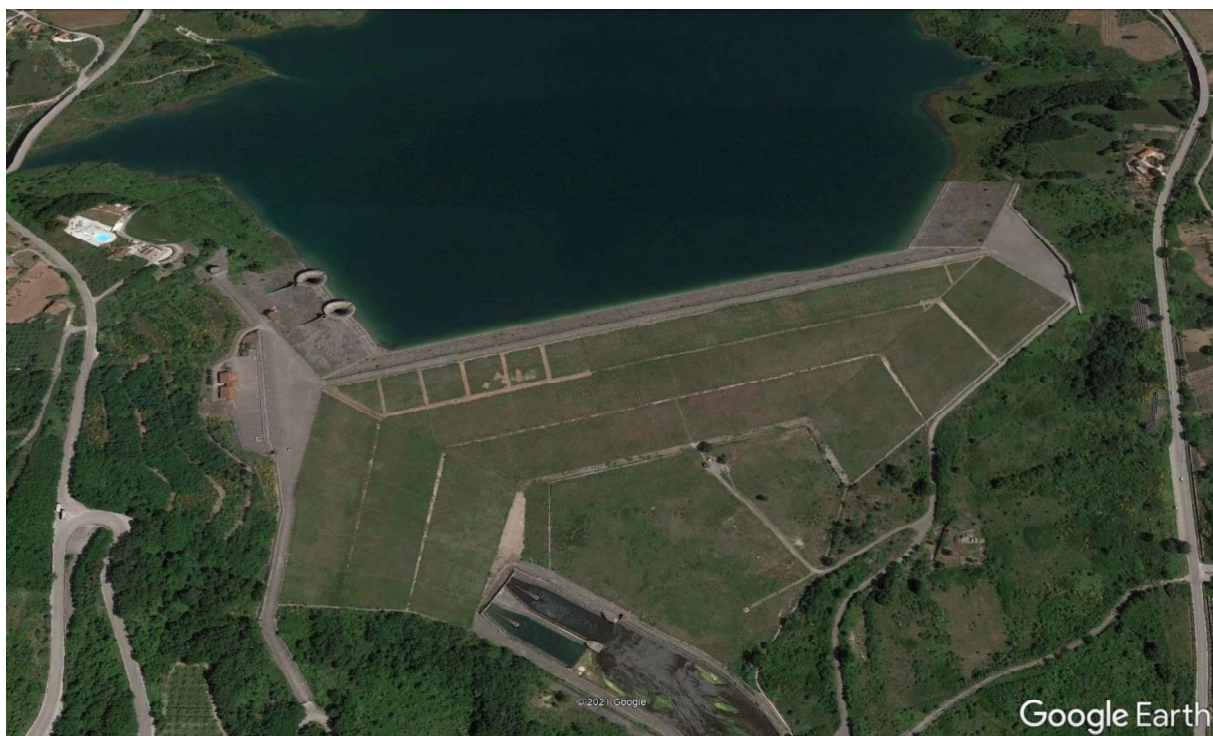
Figura 1.1 Vista aerea dell'opera di sbarramento
