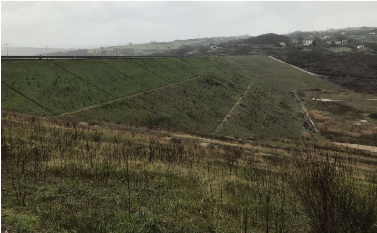
Figura 1.3 Foto del corpo diga: lato valle
