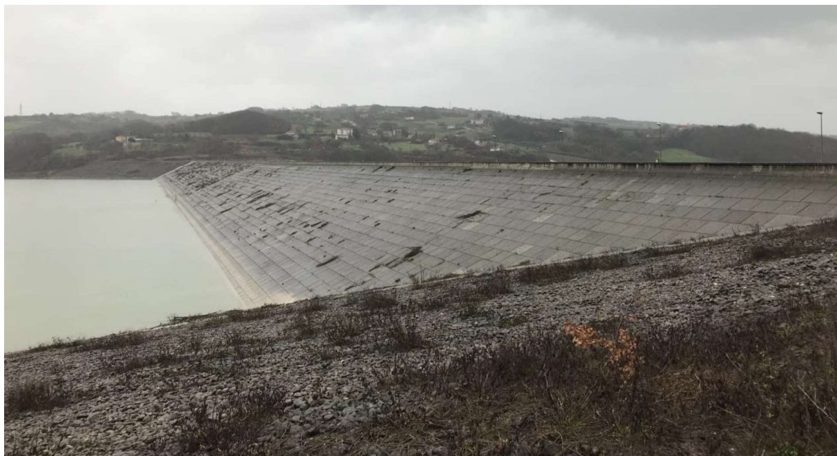
Figura 1.2 Foto del corpo diga: lato monte
